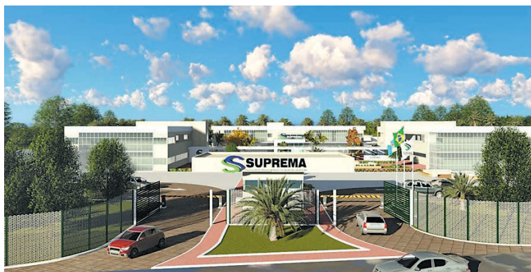
| EXPANSÃO | Novo campus da Suprema fica a 70 km de Juiz de Fora. Obras avançam
